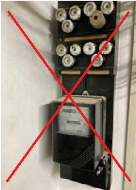
Abbildung 2: Beispiel einer Zählertafel, Zählertausch nicht möglich
